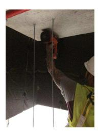
Clavado de 800 m² de lana de vidrio sobre los casetones del forjado de la planta parking de la Terminal de autobuses de Girona, con Pulsa 800E, Isogas y clavos HC6-32
