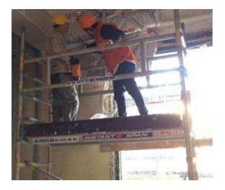
Aislamiento térmico de los zunchos perimetrales de la Casa Burés, edificio histórico en el centro de Barcelona, clavando láminas de aislamiento reflectivo con Pulsa 800E, arandelas planas Isowood y clavo C6-30.
