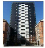
Rehabilitación del edificio Grupo Txurruka N2°B en Trápaga (Vizcaya) con instalación de fachada ventilada fijada con el anclaje B-Long y aislamiento de 80 mm de lana mineral, clavada con la clavadora de gas INSULFAST
